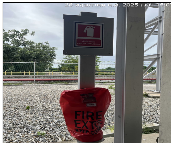
ติดตั้งเครื่องดับเพลิงแบบเคมีผงที่บริเวณสถานีวัดและควบคุมแรงดันก๊าซ (MRS)
